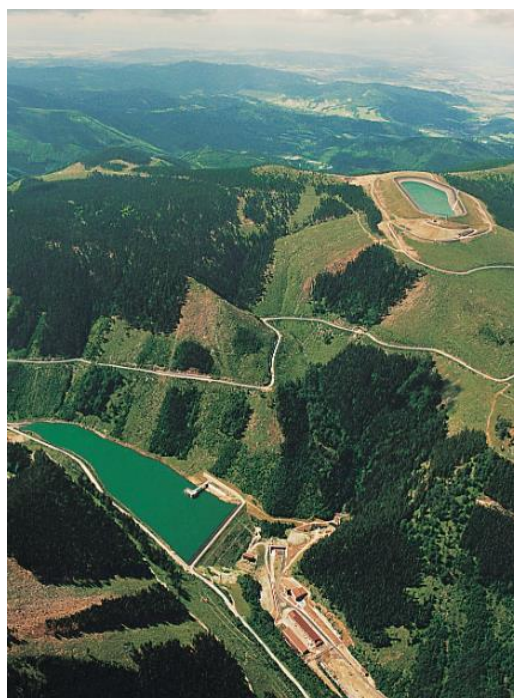
Figure 11 – Dlouhé Stráně pump storage plant.
