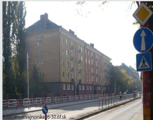
Foto: www.vajnorska16-30.f.sk Tehlový bytový dom, Nové mesto
