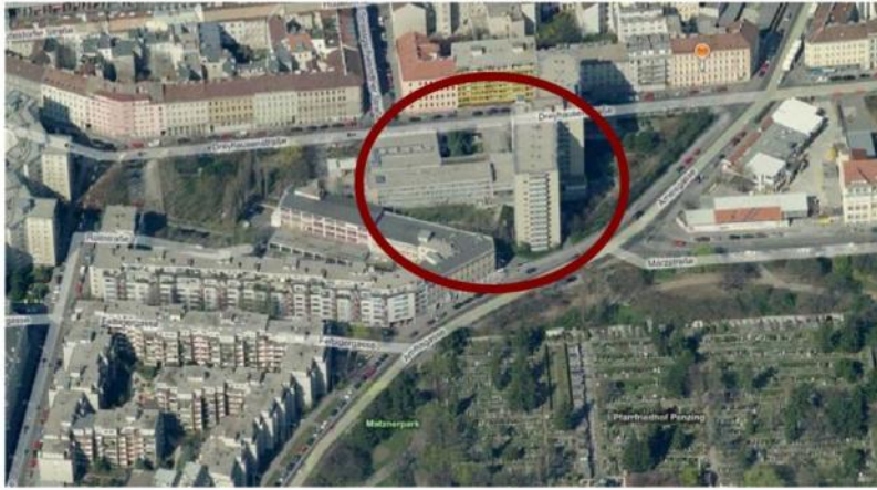
Pensionistenwohnhaus Penzing, Dreyhausengasse 29
