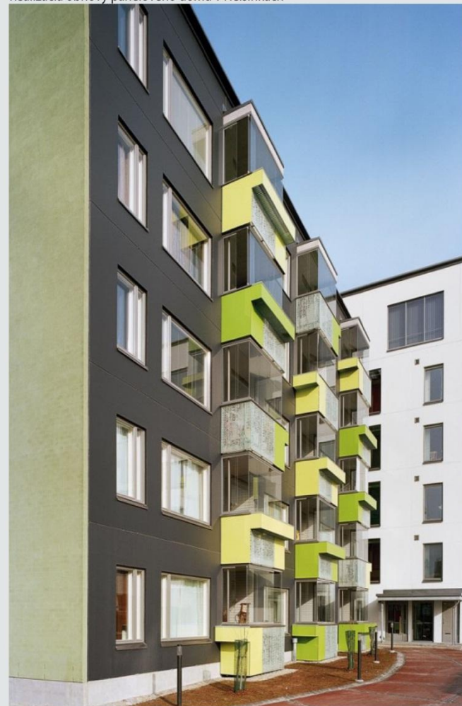
Realizácia obnovy panelového domu v Helsinkách
